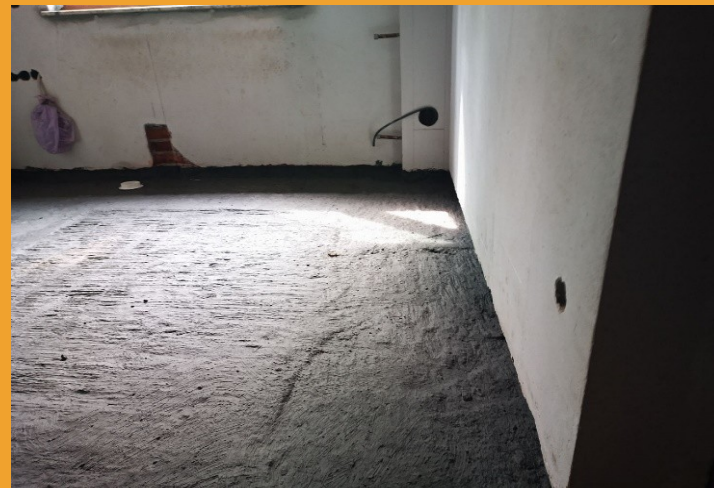
Полагане на антирадонова хидроизолация върху подовата плоча
