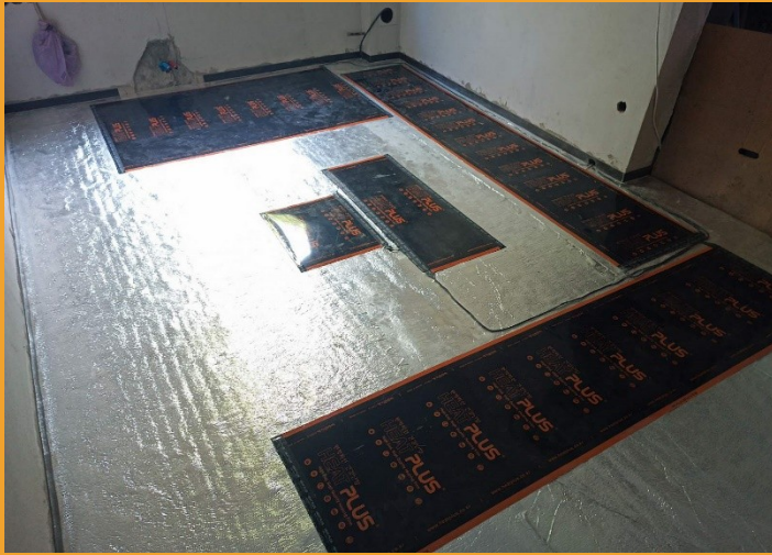
Полагане на подово отопление
