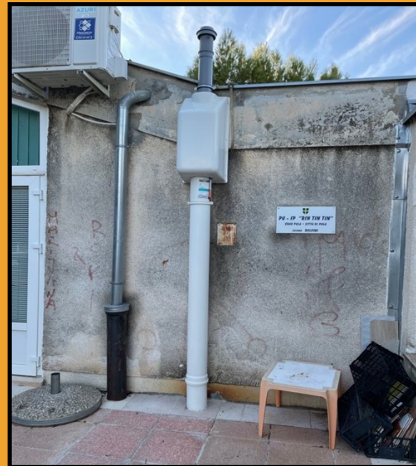
Понижаване на налягането в под контактната конструкция
