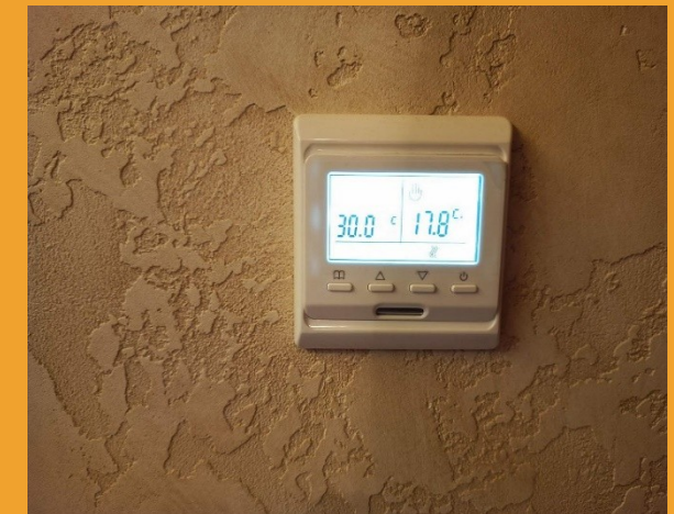
Инсталиране на контролер за подово отопление
