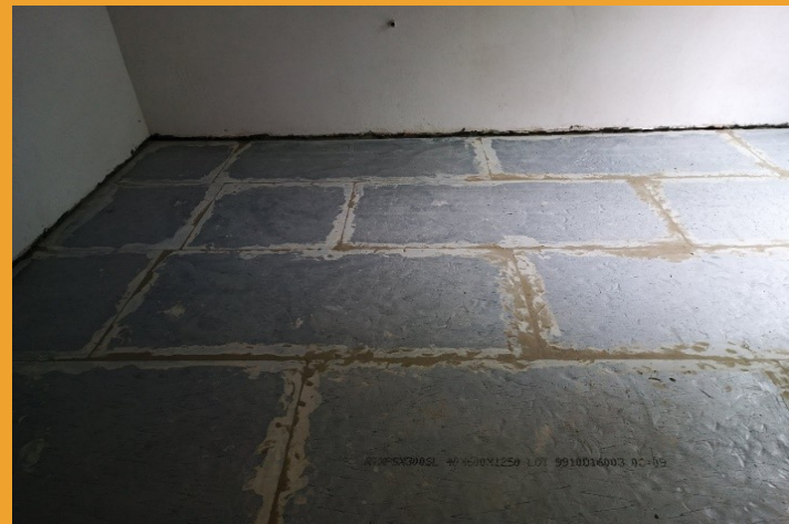
Полагане на топлоизолация върху антирадонова хидроизолация
