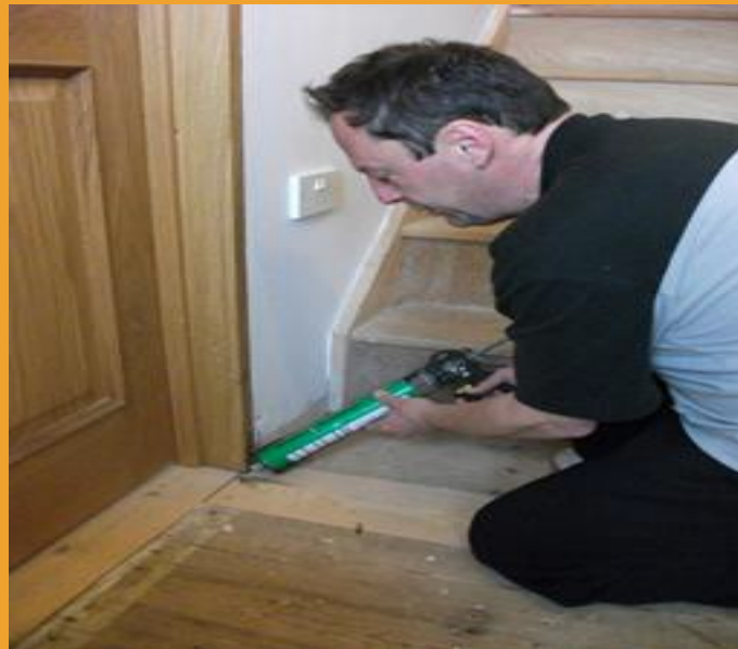
Повишаване въздухоплътността на контактния слой
